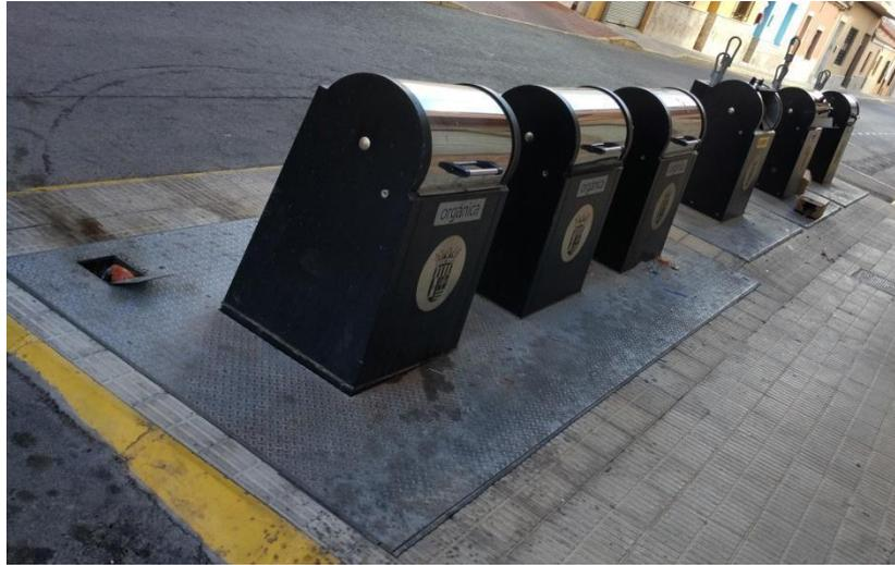
Las operaciones de descarga requieren la elevación de la isla de contenedores mediante mando a distancia o conexión de manguera hidráulica, el desplazamiento de contenedores hasta el camión para su descarga, la reubicación de contenedores vacíos en la isla y el descenso de los contenedores hasta la posición normal de recepción de residuos. Por ello el tiempo de operación es superior a otros sistemas.
